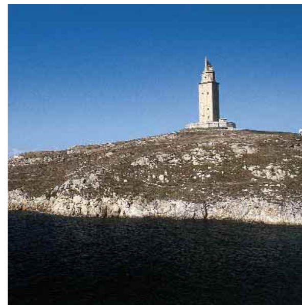
La tour d'Hercule (A Coruña)
