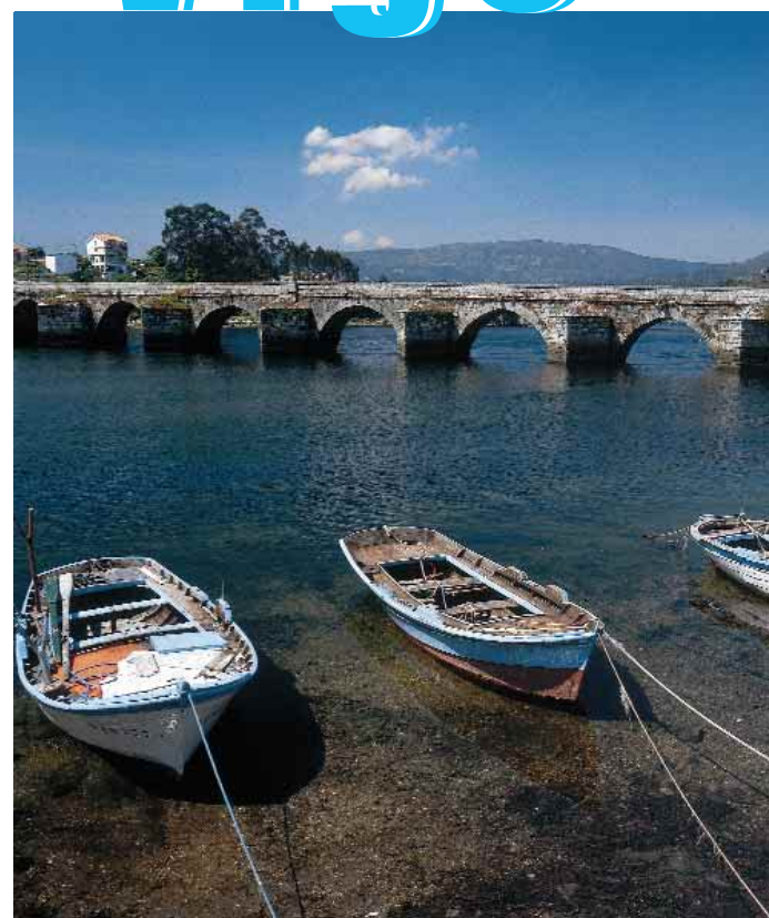
Ponte Sampaio, Pontevedra
