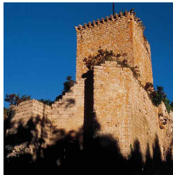
Castelo dos Andrade, Pontedeume (A Coruña)
