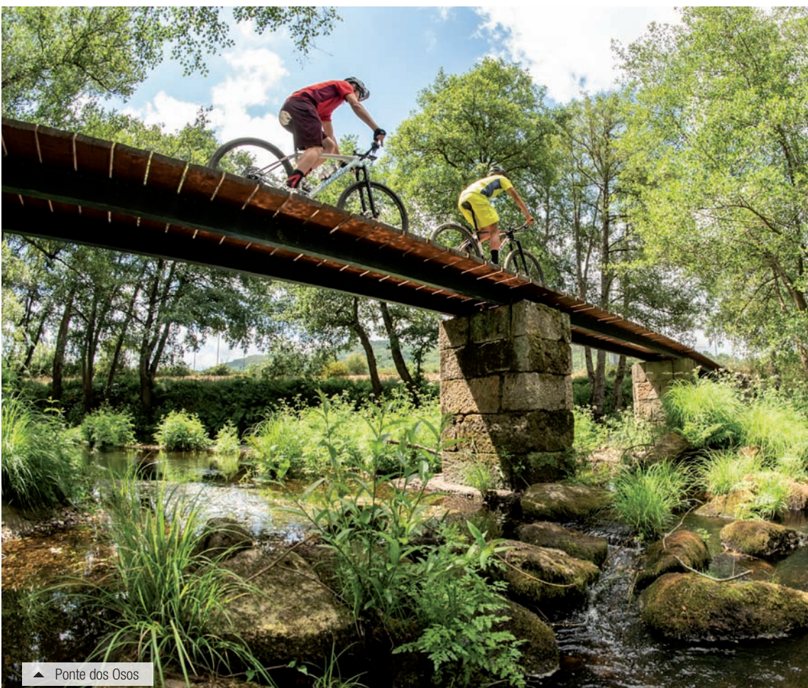
Ponte dos Osos
