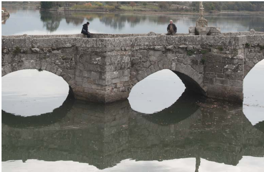
ABAJO Puente de A Ramallosa
